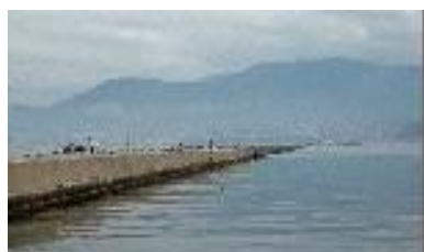
小樽港の北防波堤 出典：北海道科学大学「土木は面白い Vol. 1」より— https://www1.hus.ac.jp/~hit_doboku/doboku/1_hiroi.html
